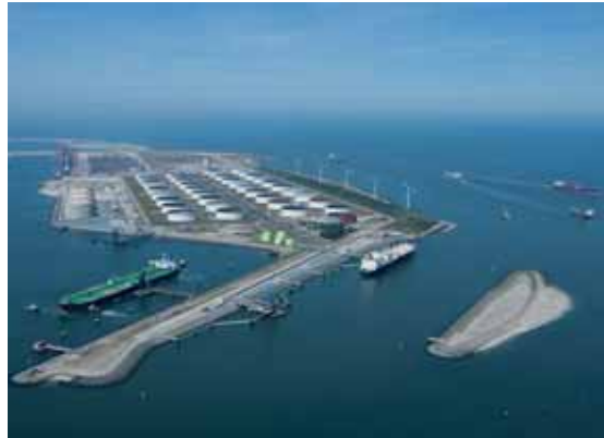
EN PORTADA: planta de regasificación Gate terminal, en Róterdam, Holanda.
