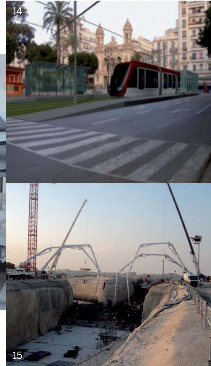
14. Metro ligero de Orán, Argelia. 14. Oran LRT, Algeria.
