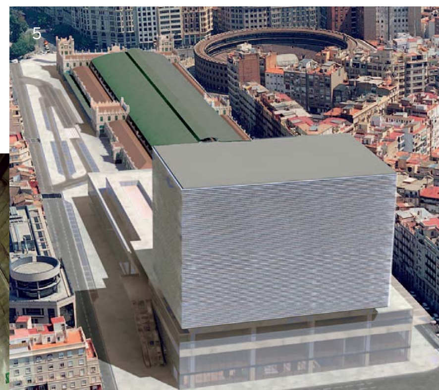
5. Estación central de Valencia, España. Proyecto Constructivo. 5. Valencia Central Station, Spain. Detailed Design.
