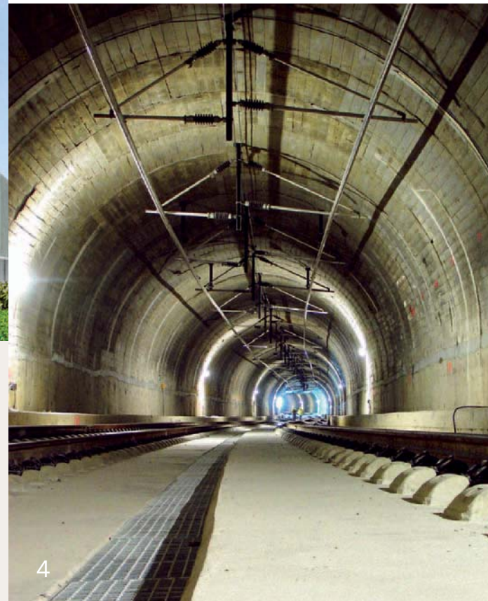
4. Línea de Alta Velocidad Madrid-Barcelona-Frontera Francesa. Tramo La Torrasa-Sants, España. Proyecto Constructivo y Supervisión de Obras. 4. HSL Madrid-Barcelona-French Frontier, La Torrasa-Sants Section, Spain. Detailed Design and Supervision of Works.
