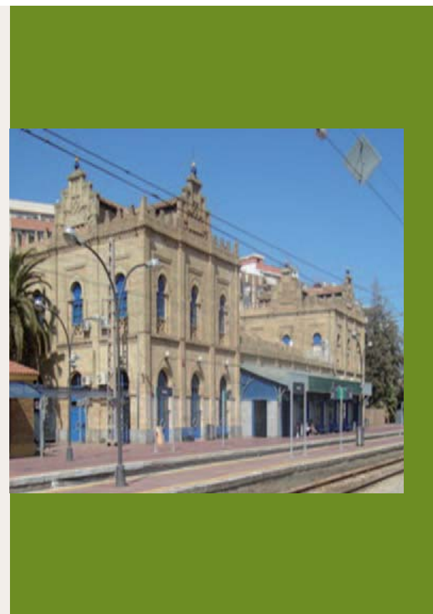
Conexión Ferroviaria de Línea de Alta Velocidad Huelva-Faro, Portugal. Estudio de Viabilidad. Connection of the High Speed Line Huelva-Faro, Portugal. Feasibility Study.
